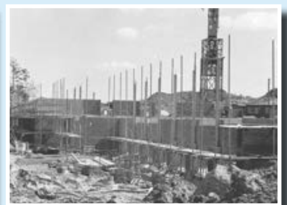
Oversigtsbillede af byggepladsen
