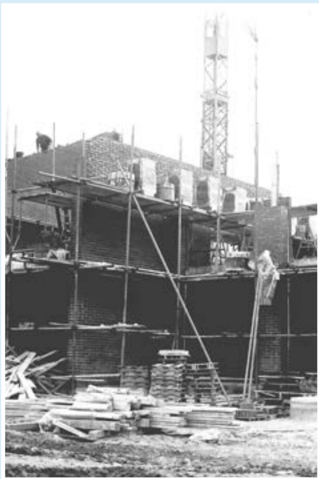
Bemærk fx stilladsbukken
