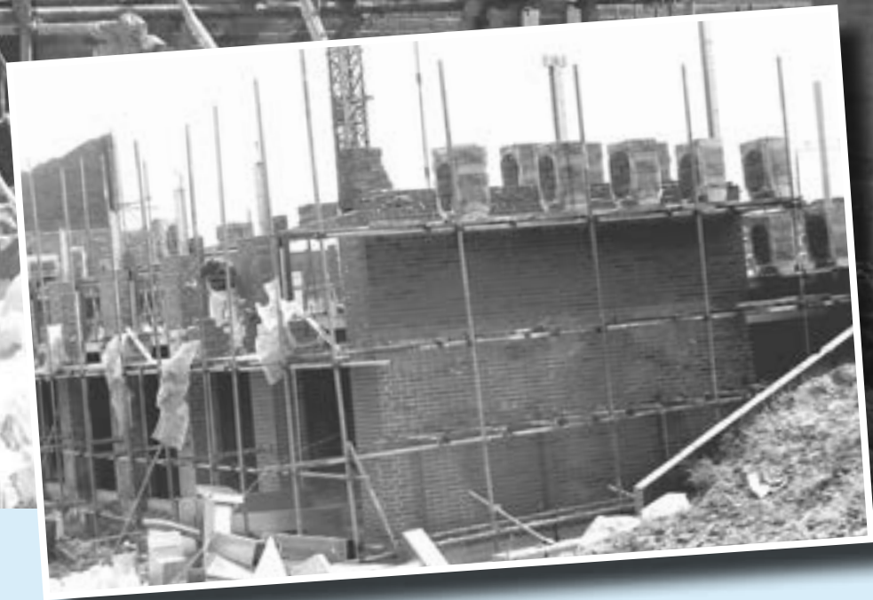
Tydeligt en-søjlet scan-rørstillads – fastgørelser.... Mjahl
